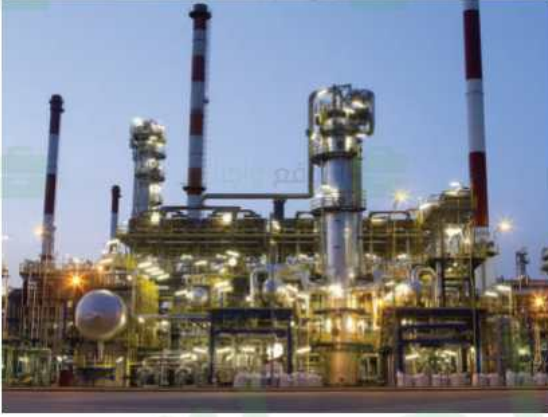
محطة توليد الكهرباء في الجبيل
